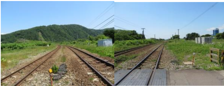
※小幌駅方面レール、静狩駅方面レール
